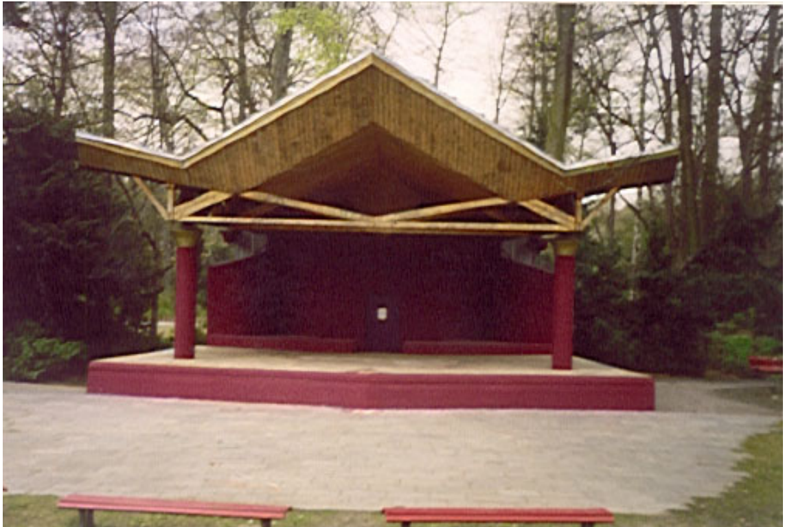
Bild 4: Der renovierte Pavillon
