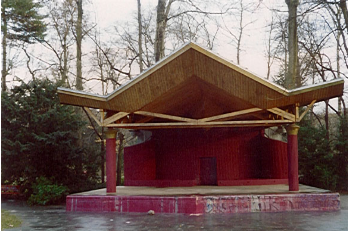
Bild 3: frisch gestrichener Pavillon mit vom Regen abgewaschener Farbe
